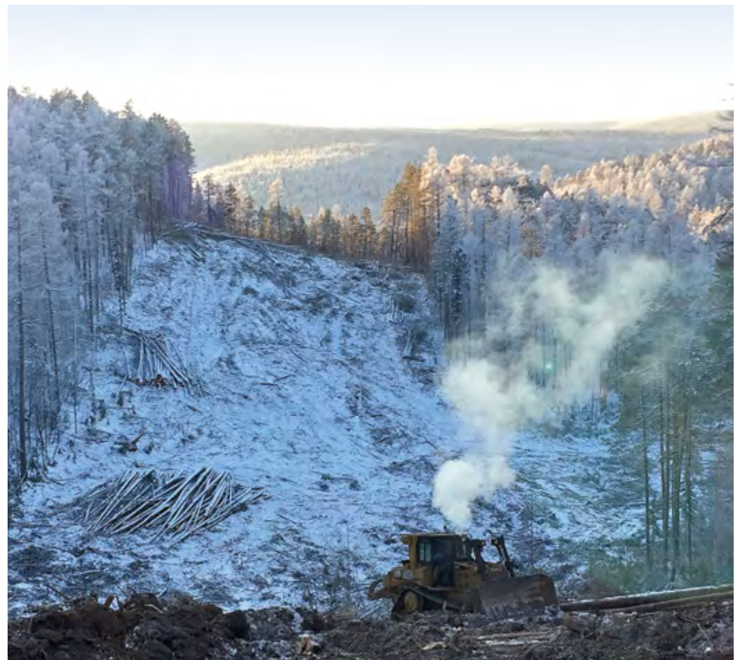
Январь 2015 года: расчистка трассы будущего газопровода
